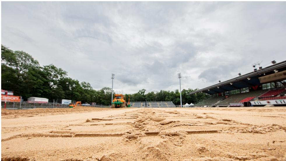
Der Sportpark Höhenberg wurde mit einer Rasenheizung sowie einem neuen Schichtenaufbau ausgestattet.
