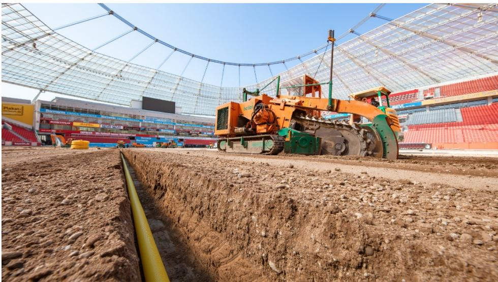
Bevor die Rasenheizung und der Hybridrasen installiert werden konnten, hat heiler umfassende Arbeiten am Unterbau durchgeführt.
